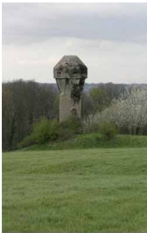
La tour d'aération du fort de Bonnelles
