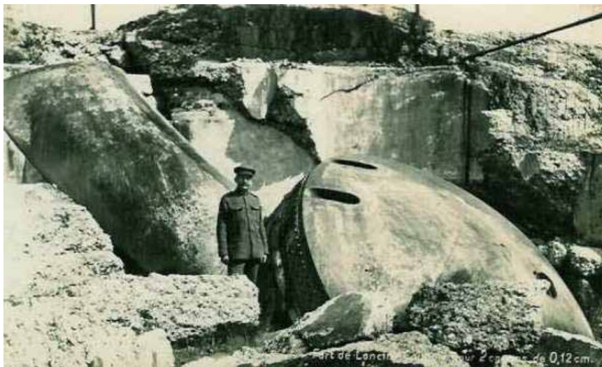
Le fort de Loncin après sa destruction
