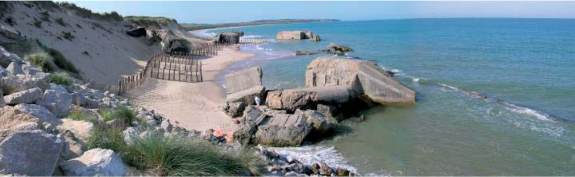
Figure 3 : exemple d'érosion côtière liée à la hausse du niveau moyen des mers : reste de bunkers appartenant au "mur de l'Atlantique" au sud de Wissant (Nord-Pas-de-Calais) (L.W. 2006).
